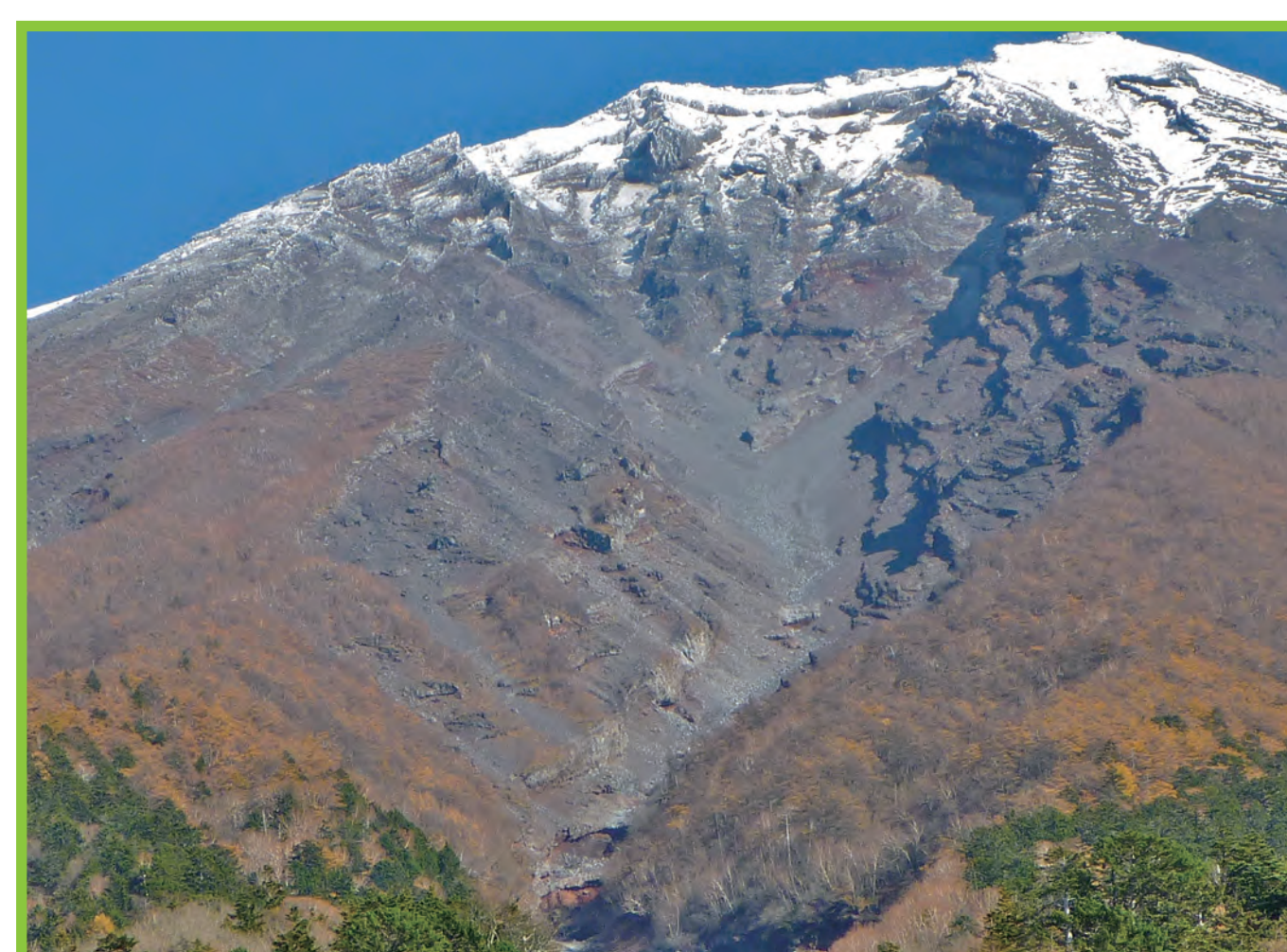
写真4 大沢崩れ全景。火砕岩と溶岩の互層からなる火山体内部の構造が見えます。
