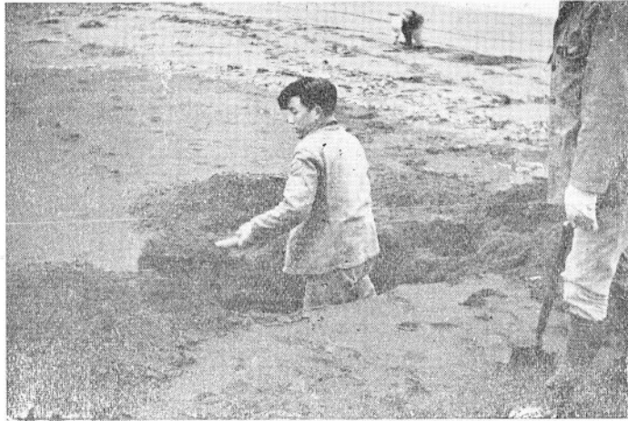
図版 11 北見国雄武町川尻の海岸で行った試験場の様子。例約1.07の深さで水がでる。
