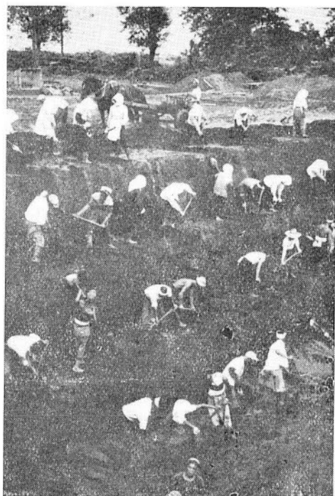
図版 24 胆振国長万部町北豊津 北日本砂鉄鉱業、K. H. 豊津鉱業所。海岸平野における採掘切羽。底部からこのように 3 段にはね上げる。水はポンプで汲み上げている。
