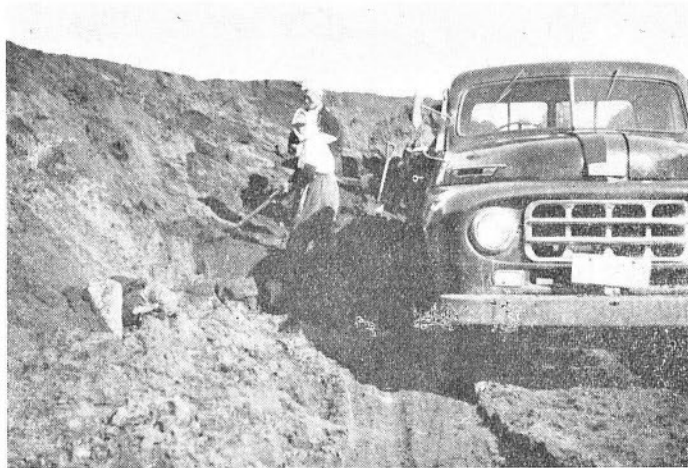
図版 18 胆振国幌別町蘭東鉱山。採掘切羽にトラックを入れている例。左は含砂鉄砂丘。
