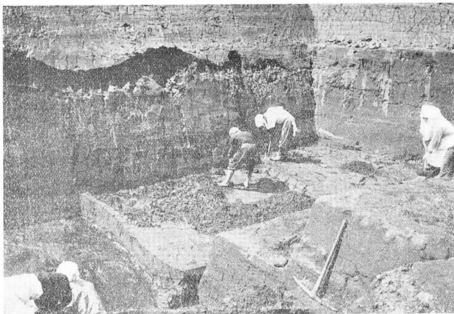
図版 29 胆振国長万部町北豊津 日鉄中央機械長万部鉱業所、左上のくずれている部分より上位は表土の粘土で、それ以下は優良な含チタン砂鉄層。砂などの夾みはほとんどない。シヨベルで丁寧にけずり戻つて探掘する。
