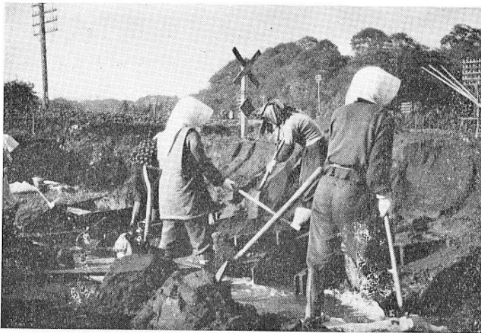
図版 8 樋流し。手前に積まれているのが精鉱。八雲町山越 山越内増田鉱山。
