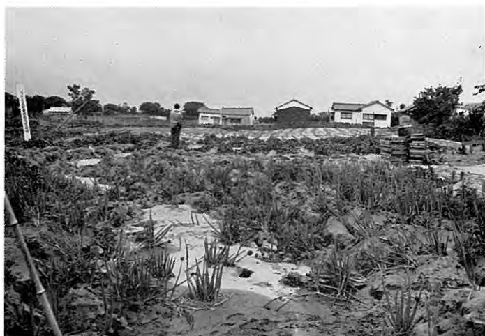
図版 45 旧信濃川河道内の波状をなす畑地の面に順応して傾いた家屋 画面のほぼ中央の家が図版 41。(黒崎村善久, 旧信濃川河道)
