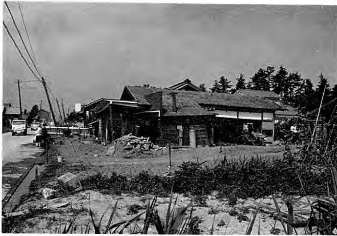
図版 32 砂丘縁辺部の押し出し 家の前半が押し出しの溜まりとなって前に傾き、後半が脚部をすくわれて後方に傾く。(越後線寺尾駅の南西約750m, 内野街道前の北側)
