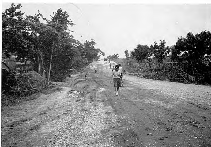
図版 48 旧信濃川河道の部分で 2 m 以上沈下した国道 18 号線
