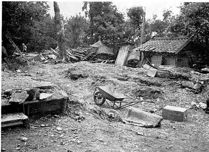
図版 43 地割れによって完全に倒壊した家屋の土台 地割れの幅約 3m。手押し車の付近が地割れのほぼ中心。 (黒崎村善久, 松田氏宅)
