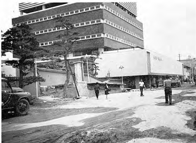
図版 30 沈下した新潟ホテルと、沈下に伴って約1.8m上昇した浄化槽
