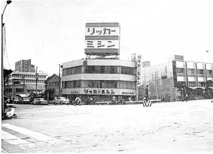
図版 26 駅前のビルディングの沈下傾倒
