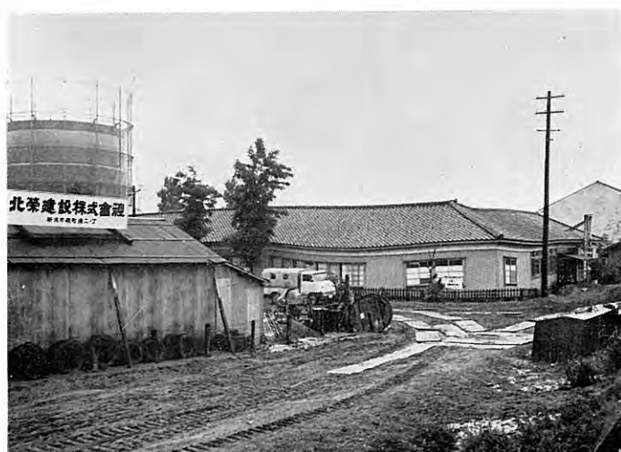
図版 8 信濃川北西岸地域磯町通りの木造家屋の不同沈下 道路は噴出した砂で覆われている。
