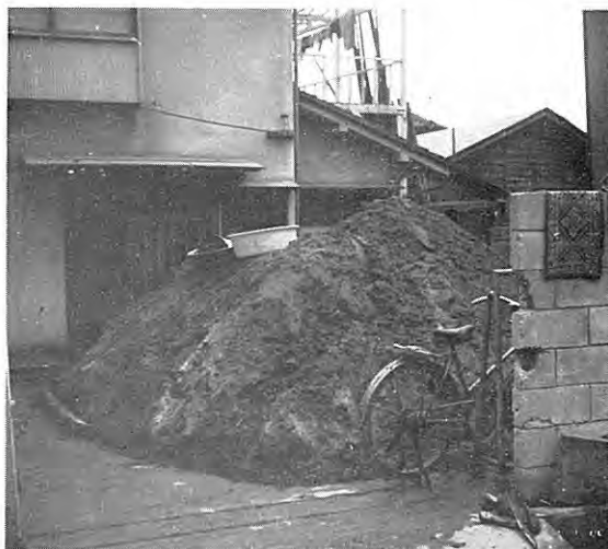
図版 24 新潟駅前付近の民家の床を押し上げて噴出した砂を屋外に積み上げる
