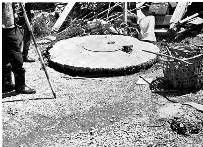
図版 65 村上市山辺里における消防井の浮きあがり (村上市災害対策本部提供)
