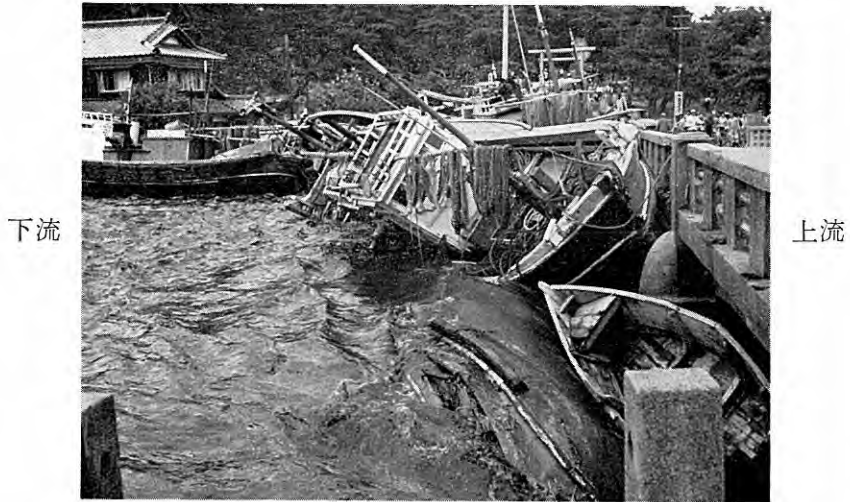
図版 78 村上市岩船・三日市間の橋梁（明神橋）下における津波の災害 津波によって上流に押しあげられた漁船。このため下流の濁水が堤防をこえて市街に浸入した。（村上市災害対策本部提供）
