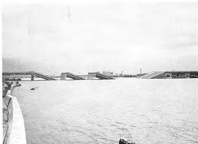
図版 20 昭和大橋 手前の堤防（信濃川の北岸）が押し出しを伴って破壊されている。 （図版 19 参照）
