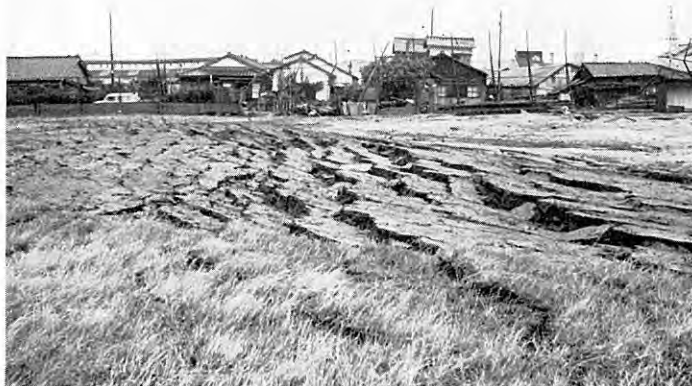
図版 13 越後線白山駅西方約 750 m 付近の同線南側広場の局部的沈降部と地割れ群 (N 6~7° E で鉄道に平行) 沈降部では砂を噴出している。地割れの落ちの側が沈降側と反対になっていること、家屋や塀もわずかながら傾いていることに注意。
