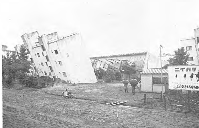
図版 6 傾倒した川岸町の県営アパート
