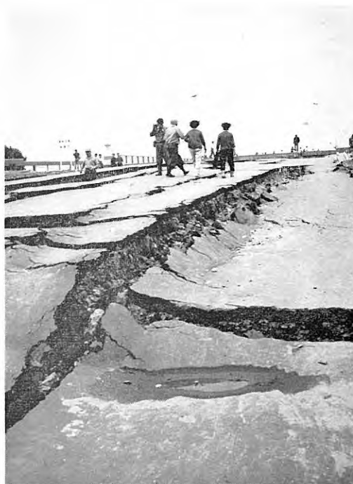
図版 21 昭和大橋北岸とりつけ部の盛土の地割れ 地割れの落差は約 60 cm。（図版 19 参照）
