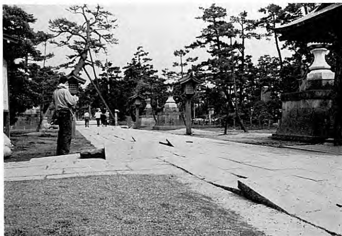
図版 1 白山神社参道 (N60°W) の敷石のまくれ上がり 全体で約40cm重複している。
