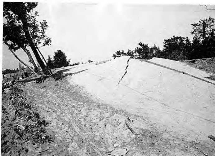
図版 36 内野街道中の局部的隆起 高さ約 3 m, 長さ約 25 m (図版 34 と同一地点)
