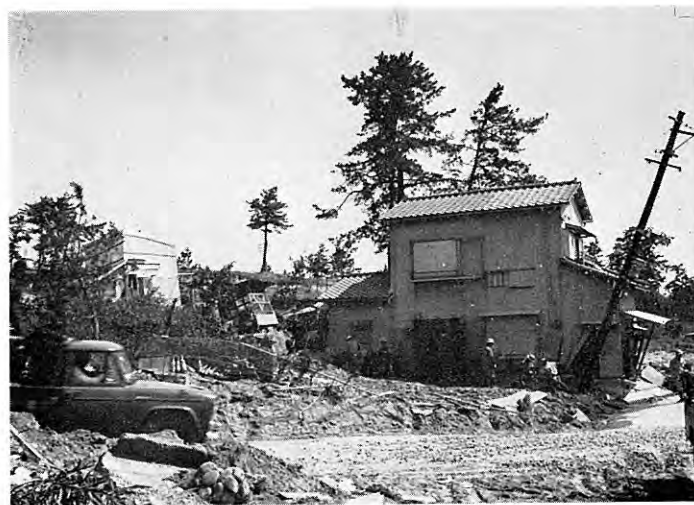
図版 35 図版 34 の右側の部分 押し出し（地すべり）前縁の部分 前の家は建物の部分だけ土台をはなれて前に押し出され、後の家は脚部をすくわれて後方に傾く。
