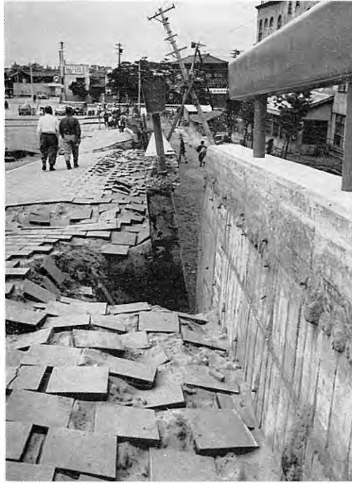
図版 22 昭和大橋北岸とりつけ部の盛土擁壁の破壊
