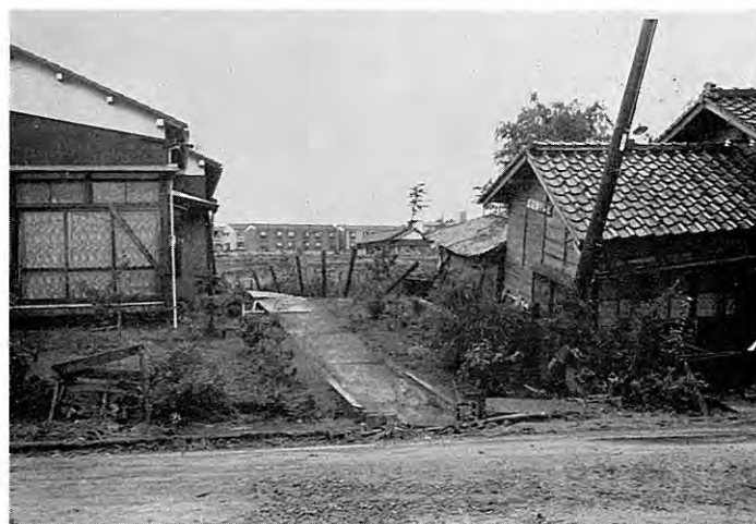
図版 37 砂丘縁部の押し出しを伴う波状うねり 左の家は地震前にくらべて約 2 m 上昇し, 右の家は道路側に著しく傾いている。杭の列も上昇によって扇形に開いている。 (越後線寺尾駅の南東約 2 km)
