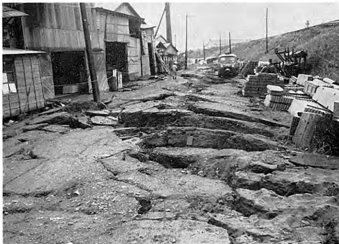
図版 17 越後線に平行な道路の地割れ 道路に直角な方向（信濃川の方向）の地割れと道路方向の地割れとが発達する。 （図版 16 の左手の道路に連続する）
