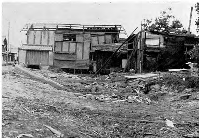
図版 80 新潟県岩船郡神林村塩谷部落 (1) 地盤の陥没状況を示す。手前の空地は倒壊家屋整理跡。 北より南を望む。(鈴木泰輔撮影)
