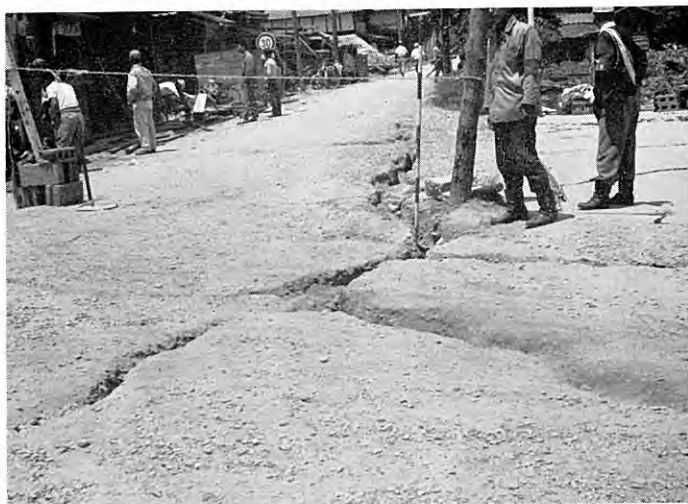
図版 76 村上市八日市の道路面に生じた地割れ (村上市災害対策本部提供)
