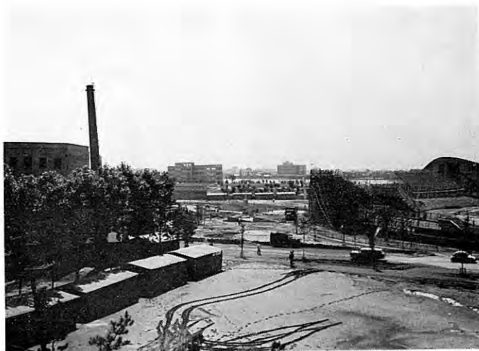
図版 2 県庁から信濃川方向を望む スタンドは不同沈下して内側に傾斜し、煙突や信濃川沿岸部のビルディングも傾斜している。スタンドの不同沈下に伴って、グラウンドに弧状の地割れが生じている。この付近は噴砂も著しく、右下には噴砂孔がみられる。
