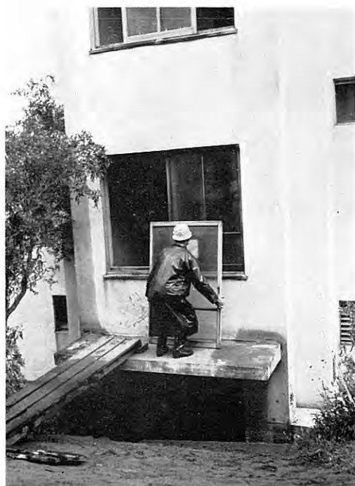
図版 7 1 m 以上沈下した川岸町の県営アパート 南側（手前）に少し傾いている。
