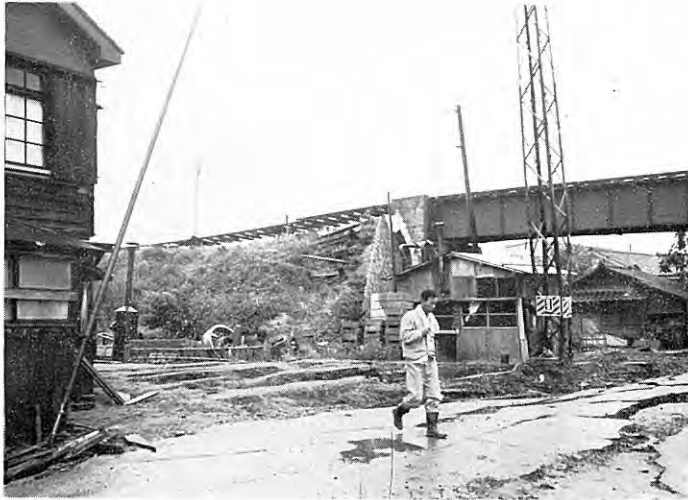
図版 16 越後線信濃川鉄橋北岸付近の盛土崩壊と地割れ 信濃川方向（手前の道路に平行）の地割れがそれとほぼ直角方向の道 路上にも発達している。
