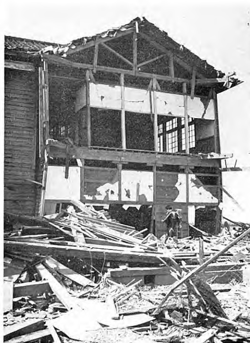
図版 52 鶴岡市京田幼稚園校舎の倒壊 (鶴岡市災害対策本部提供)
