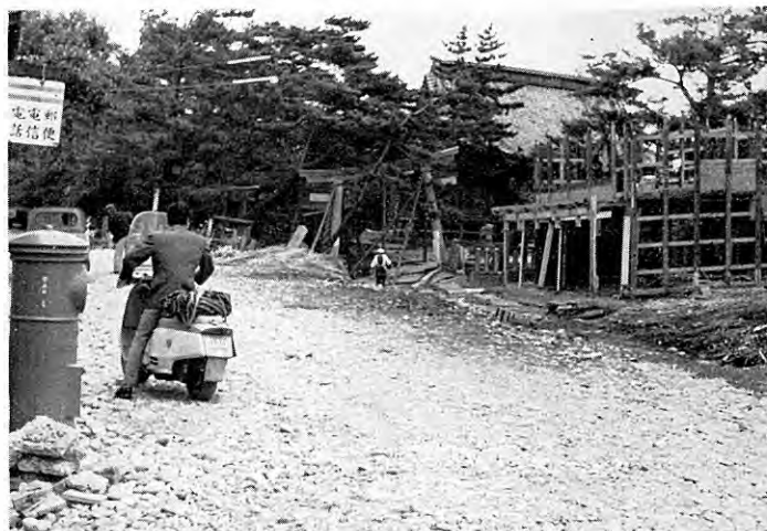
図版 81 新潟県岩船郡神林村塩谷部落 (2) 神社の鳥居が傾いている。手前の民家は半壊整理中 T字路付近より北を望む (鈴木泰輔撮影)
