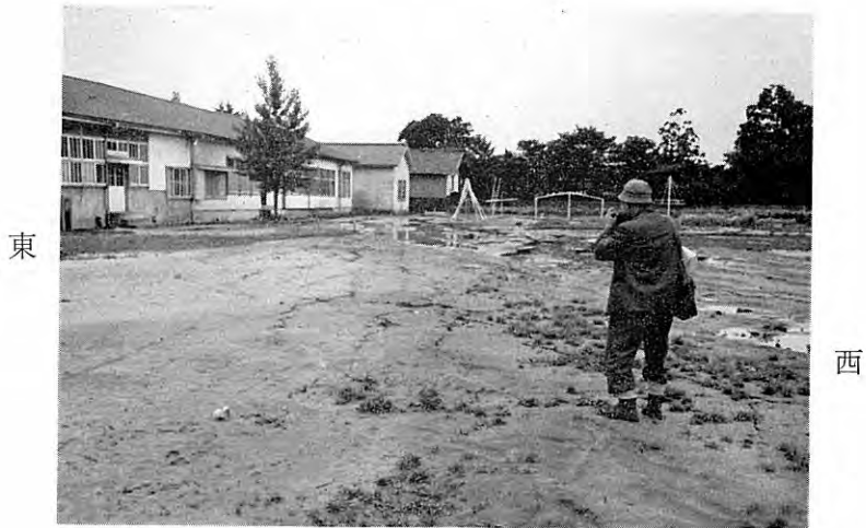
図版 84 新潟県北蒲原郡中条町 (1) 大出小学校校庭に生じた地割れ。 校庭の北西部は若干沈下して排水不良となり、調査当時 (39.6.22) 水溜りが生じていた。(鈴木泰輔撮影)
