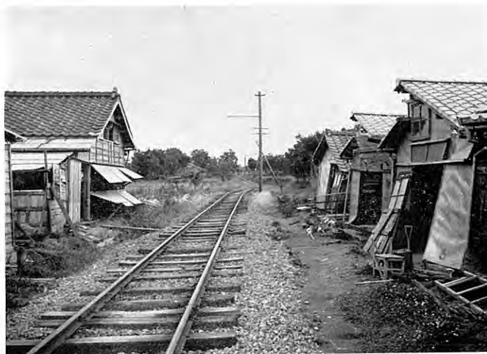
図版 38 黒崎村旧信濃川河道内の鉄道（新潟電鉄）と民家の破壊 鉄路は彎曲し、鉄道盛り土は崩壊沈下している。（写真中央部）
