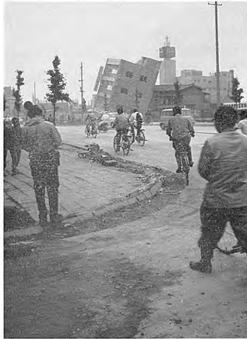
図版 28 駅前ビルディングの沈下傾倒 (約 18^{\circ} ) 歩道の縁の部分がまくれ上がっている。
