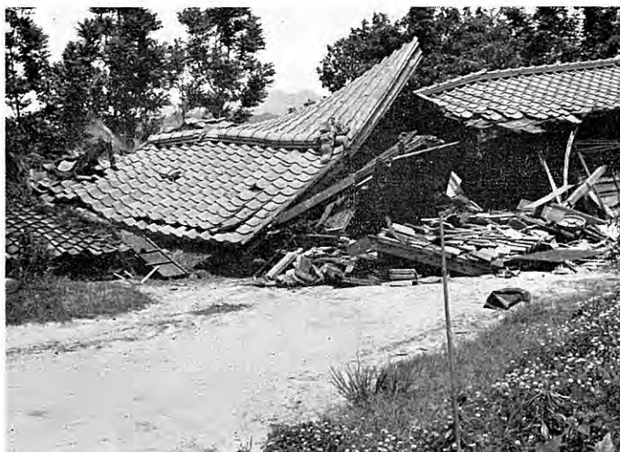
図版 74 村上市八日市における家屋の倒壊 (1) (村上市災害対策本部提供)
