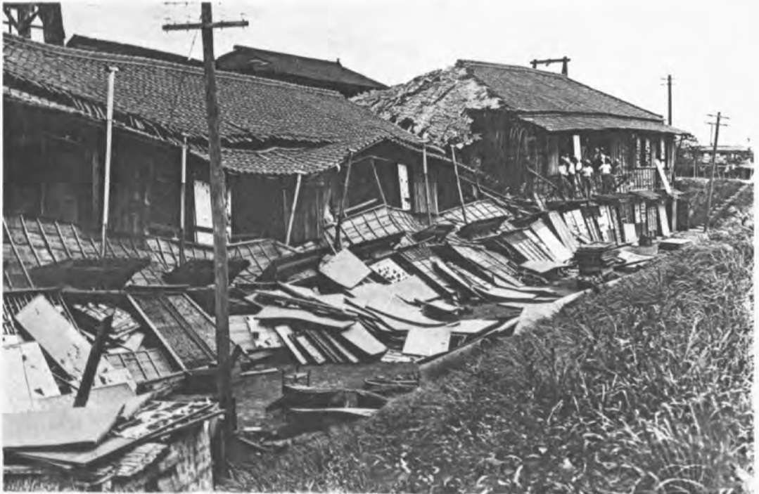
綾瀨橋附近前田鐵工所長屋ノ倒潰
