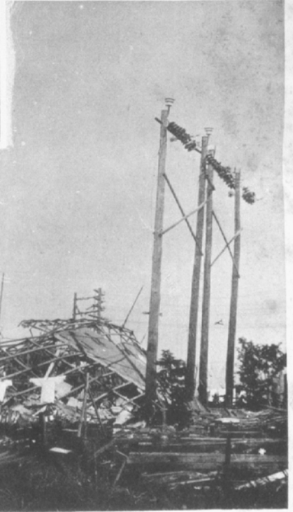
池上東京電燈株式會社 池上變電所ノ潰倒
