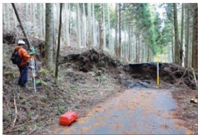
(写真1) 福島県浜通りの地震(2011.4.11)に伴い出現した道路を大きく食い違わせる地震断層の緊急測量調査
