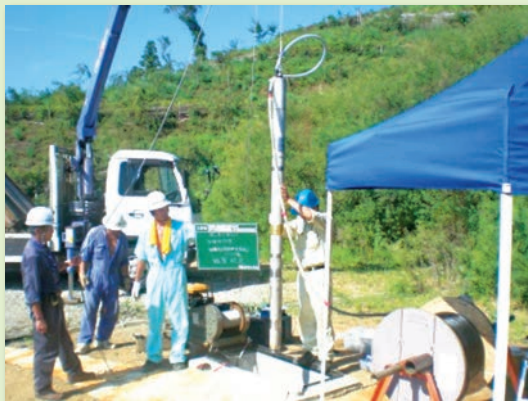
井戸用の地震計の設置風景。地下数百mのところへ地震計を設置することで、人工ノイズ(車や電車、人の行き来など)が劇的に小さくなります。これにより、地表の観測では検出できない微弱な信号も捉えることができるようになります。
