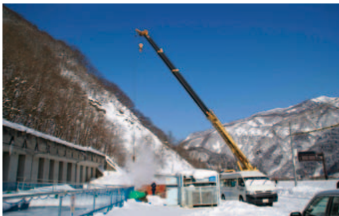
図4 長野県小谷村実験フィールド。
