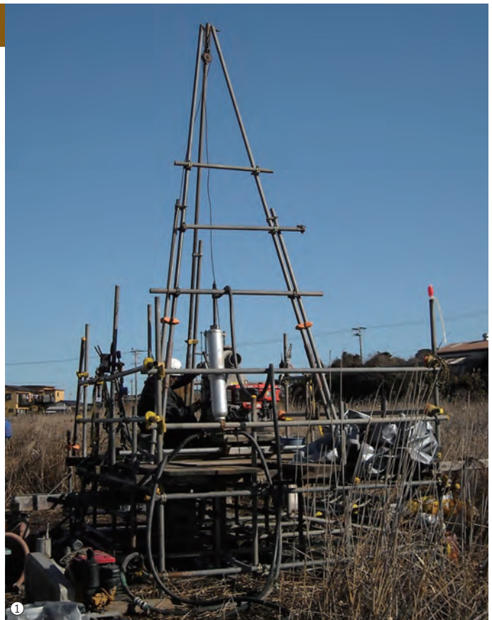
① 機械ボーリングの調査風景。(2009年1月 三重県志摩市) ② 機械ボーリングの調査風景。状況によって、櫓の大きさや形状を変える。(2011年1月 静岡県富士市)
