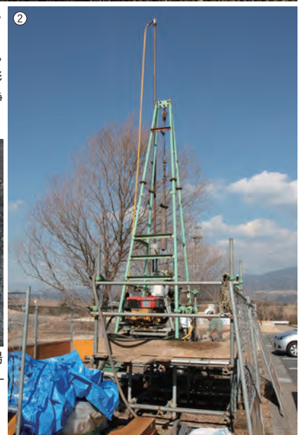
① 機械ボーリングの調査風景。(2009年1月 三重県志摩市) ② 機械ボーリングの調査風景。状況によって、櫓の大きさや形状を変える。(2011年1月 静岡県富士市)
