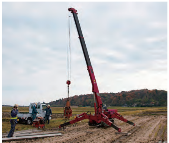
小型クローラークレーンを使用したジオスライサー調査。 (2009年11月 福島県南相馬市)
