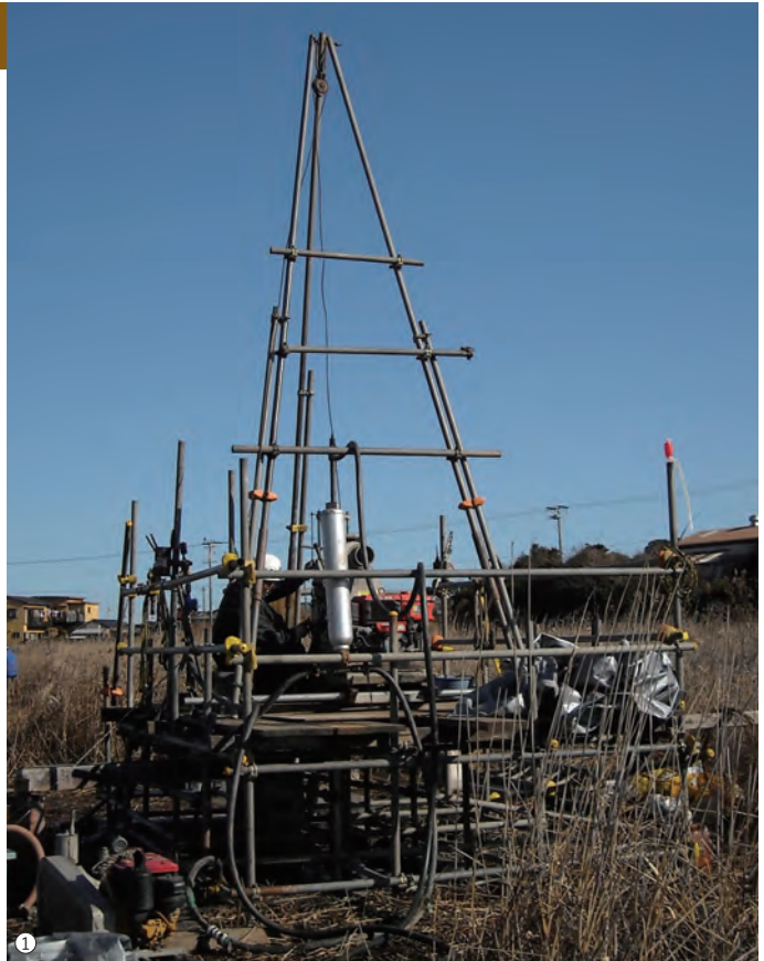
① 機械ボーリングの調査風景。(2009年1月 三重県志摩市)
