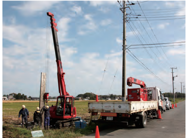
左側の重機がクローラークレーン、右側がトラッククレーン。 (2012年10月 茨城県北茨城市)
