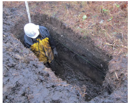
ピット調査の様子。園芸用シャベルを使用して、人力で掘削。（2012年11月 青森県三沢市）（写真撮影・提供 谷川晃一朗）
