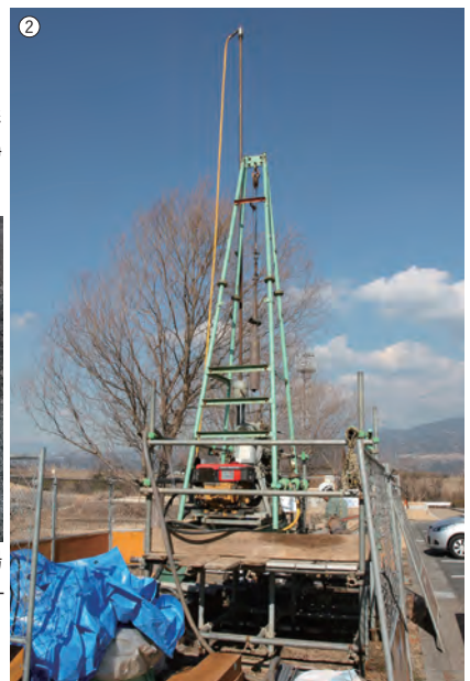
② 機械ボーリングの調査風景。状況によって、櫓の大きさや形状を変える。(2011年1月 静岡県富士市)
