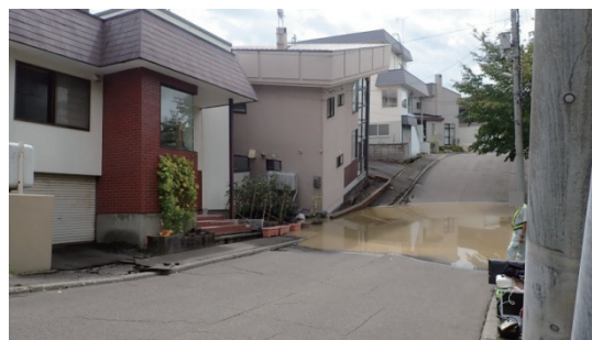
図2. 地盤液状化に伴う陥没（札幌市清田区里塚）
