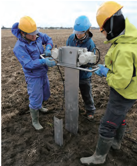
山武市における掘削風景
