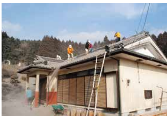
図1 屋根からの火山灰の除去(宮崎県都城市). 作業中に屋根から転落する事故が多発しました。
