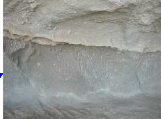
層状の凝灰岩の産状（鬼ヶ城） 左写真のベンチ部分
