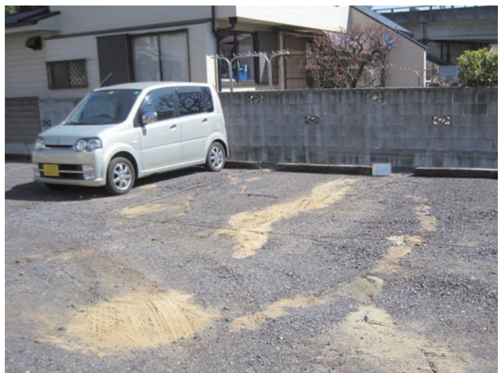
写真2 土浦市東真鍋町で確認された噴砂跡。
