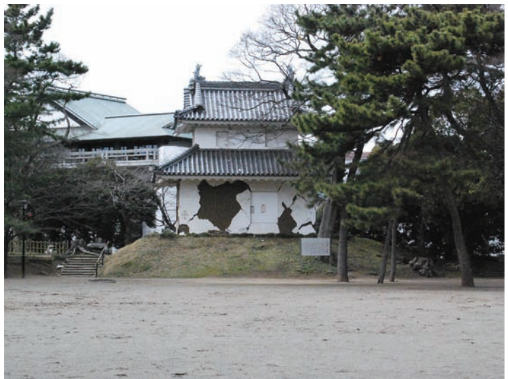
写真1 土浦城西櫓。外壁が大きく損傷していました。
