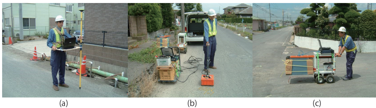
第 5 図 詳細追加調査風景. (a) ハンディ RTK-GPS による測量，(b) 400MHz アンテナ，(c) 2GHz アンテナ. Fig.5 Scenery of detailed additional survey. (a) The measurement by handy RTK-GPS. (b) 400 MHz antenna. (c) 2 GHz antenna.
