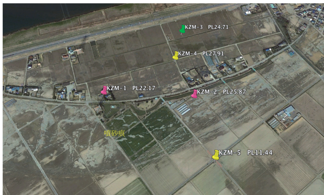
第 16 図 神崎地区における噴砂状況 (Google earth を使用)
