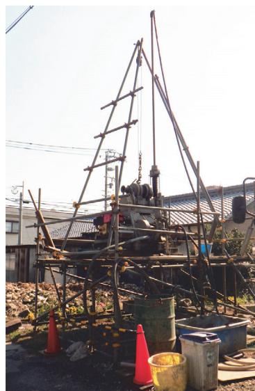
第 5 図 オールコアボーリングによる掘削 (SRT-21) Fig.5 Coring by all-core drilling system.
