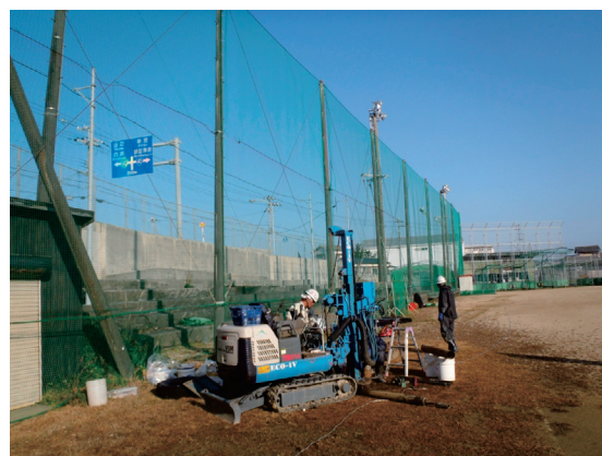
第9図 串本古座高等学校におけるボーリング調査の様子
