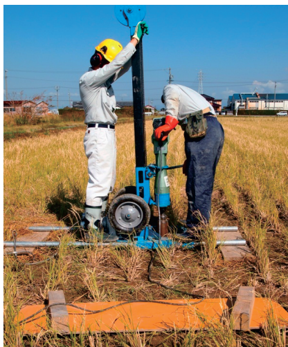
第6図 定方位簡易ボーリング実施状況
