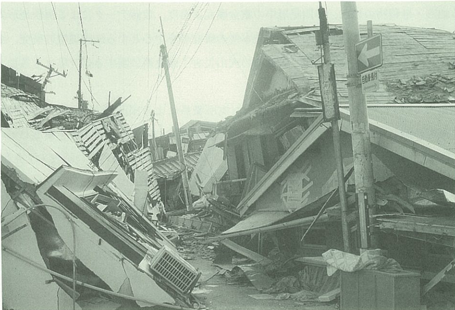
付図2 兵庫県南部地震直後の被害状況
