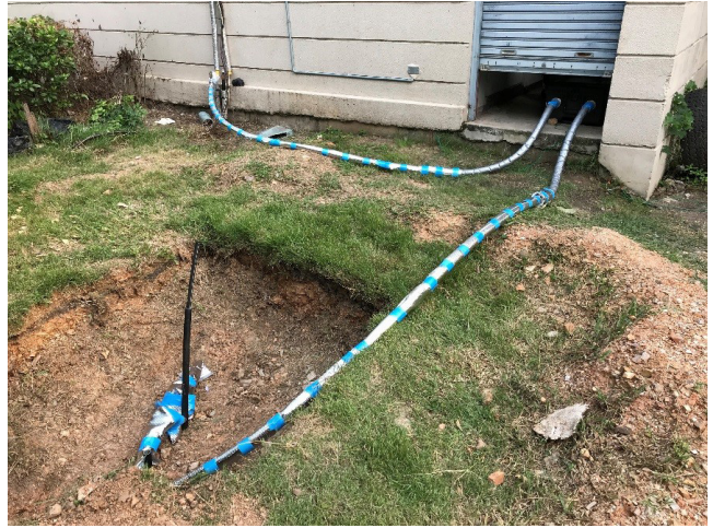
写真4 TRT実施状況
