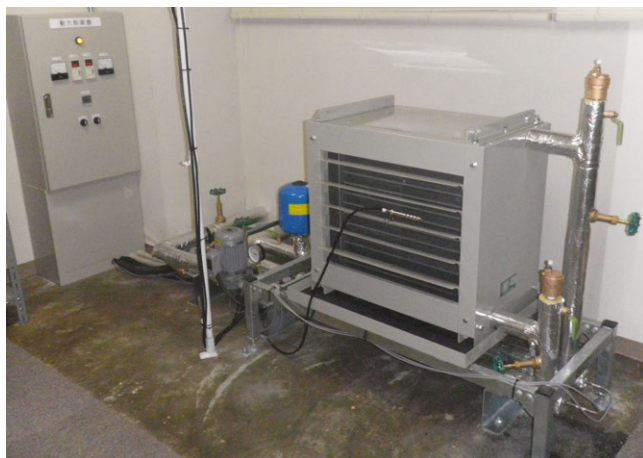
写真1 プレートフィンクーラー
