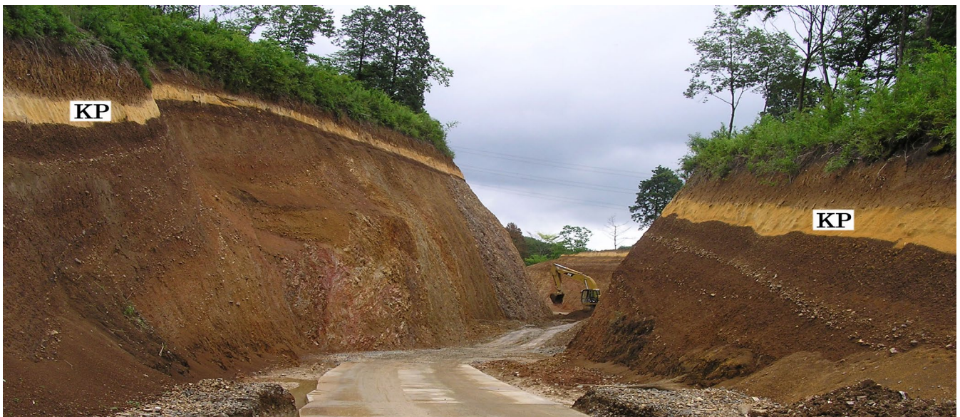
写真2 切り割りに現れた鹿沼軽石(KP)層・厚さは50cm程。(栃木県益子町で)
