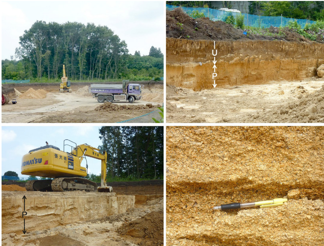
写真3 鹿沼土を掘る。(左上) 畑地や雑木林の中に採掘場が設置されています。(右上) 採掘場の脇に見られるローム層の断面。(左下) 表土・上部ロームが見事に剥土され鹿沼軽石層がむき出しになっています。(右下) 鹿沼軽石層の産出状態。U: 上部ローム層, P: 鹿沼軽石層
