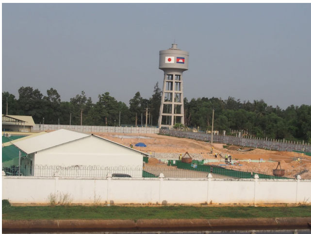
写真2 日本が支援した浄水施設.
