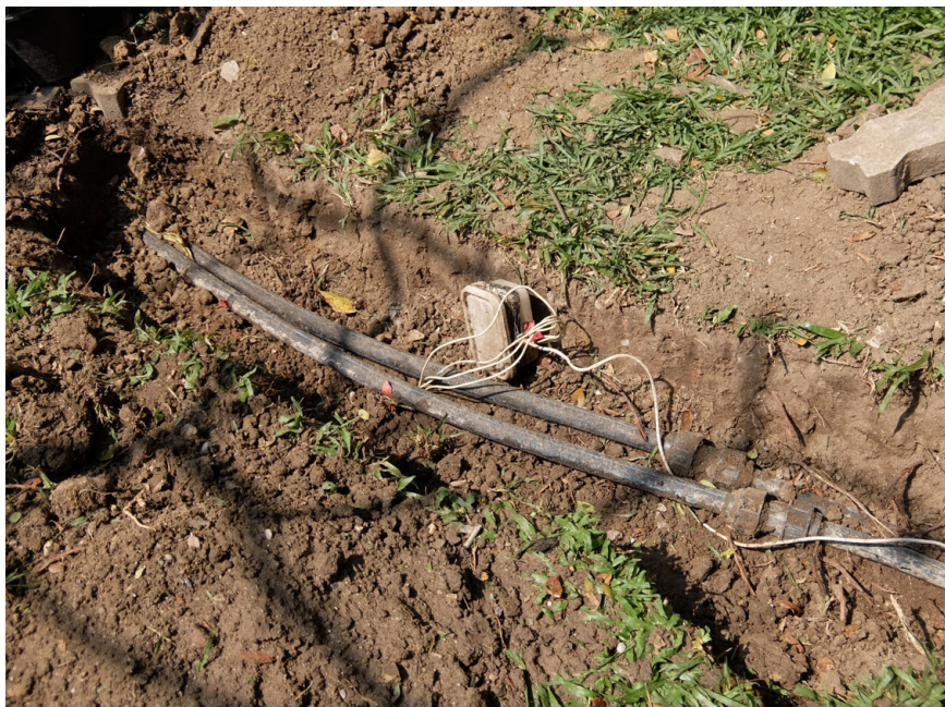
写真1 既設の熱交換器の配管を掘り起こす.
