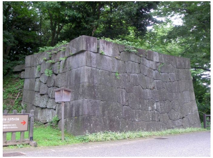
写真2 土橋門台西側（南面と東面）
