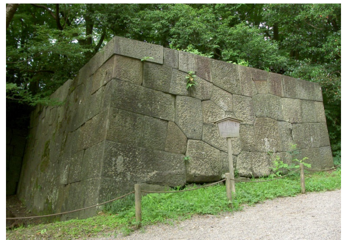
写真6 鉄門台北側（西面と南面）
