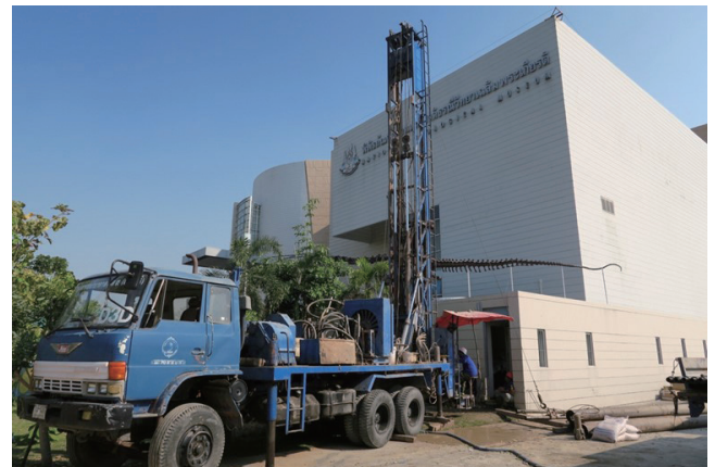
写真1 タイ国立地質博物館における掘削風景。
