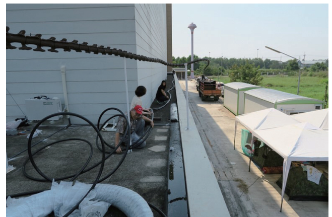
写真2 熱交換パイプを伸ばし、熱交換井への挿入準備。
