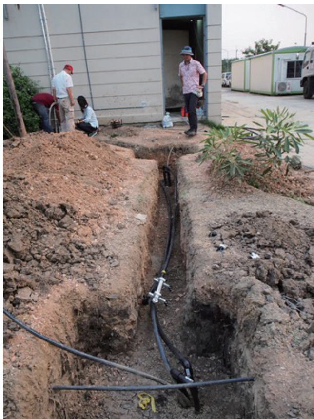
写真3 トレンチと配管パイプ。
