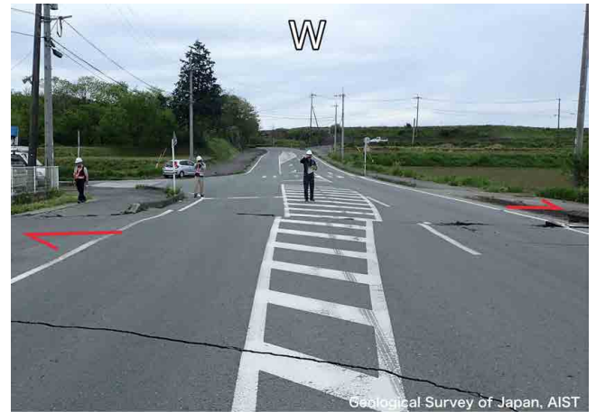
写真12 土山集落西方の舗装道路に見られる右横ずれ変位。写真は西方向に向かって撮影。(2016年4月16日撮影)
