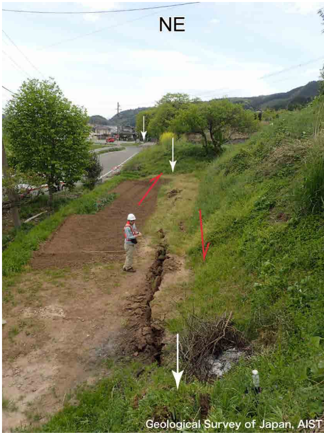
写真5 三竹集落の畑に見られる縦ずれ変位。写真は北東方向に向かって撮影。上下変位量は約35 cm。奥に見える交差点付近にも同様の変位が連続。(2016年4月16日撮影)
