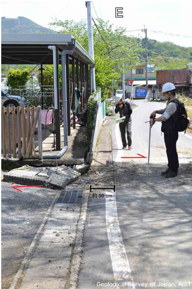
←写真 14 上高野集落の舗装道路に見られる右横ずれ変位。写真は東方向に向かって撮影。側溝を基準とした時の右横ずれ変位量は約 50 cm。(2016 年 4 月 17 日撮影)
