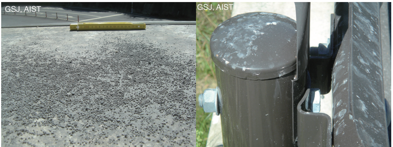
写真3 自動販売機の上に残る火山礫 (左) とガードレールに付着した“泥雨”の跡 (右). 10月8日夜の雨のため一部は失われている (竹田市米賀, 10月11日撮影).
