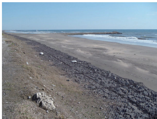
第11図 一松海岸において海岸侵食対策のため整備された護岸堤とT字突堤(ヘッドランド)。
