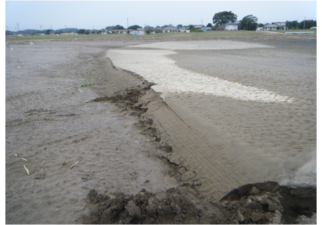
写真 8 破堤により形成された南東～南へ伸びる舌状の高まり。3D デューンの複合体から成る。
