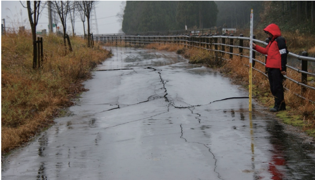
写真4 白馬村飯森集落の東，舗装道路にみられる撓曲変形。写真は北へ向かって撮影。上下変位量は約70 cm.
