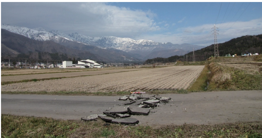
写真6 白馬村神城堀之内にみられる舗装道路の短縮変形。写真は北へ向かって撮影。水平短縮量の総計は約36 cm。右奥の送電線鉄塔から左手の田圃にかけて、奥村ほか（1998）による堀之内地区トレンチ調査および今泉ほか（1997）による地層抜き取り調査が実施され、ほぼ水平な断層と撓曲変形が確認されている。
