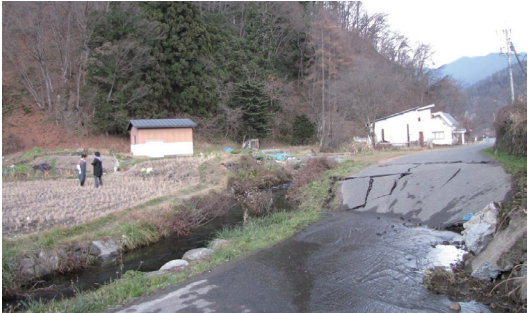
写真1 白馬村塩島集落にみられる地表地震断層. 写真は北東へ向かって撮影. 廣内ほか(2014)により, 西側低下の上下変位約90 cmが報告されている.
