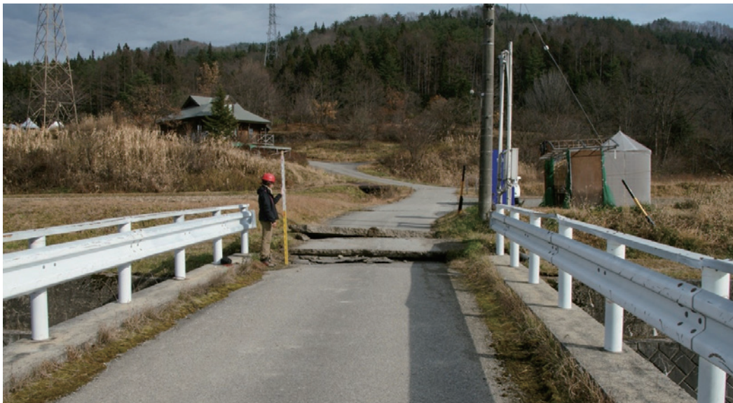
写真5 白馬村飯田集落の東，姫川にかかる橋にみられる水平短縮。写真は東へ向かって撮影。水平短縮量は約60～90 cm.
