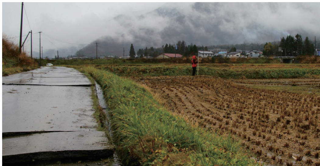
写真3 白馬村飯森集落の田圃にみられる撓曲変形. 写真は南へ向かって撮影. 西側低下の上下変位量は約30~50 cm.
