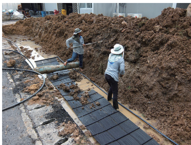
写真4 チュラロンコン大学サラブリ実験場での熱交換器(Gカーペット)埋設作業。
