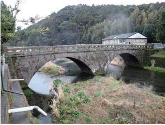
写真4 1904年に石材を使って構築された祓川大園の石橋（鹿屋市下祓川町）。
