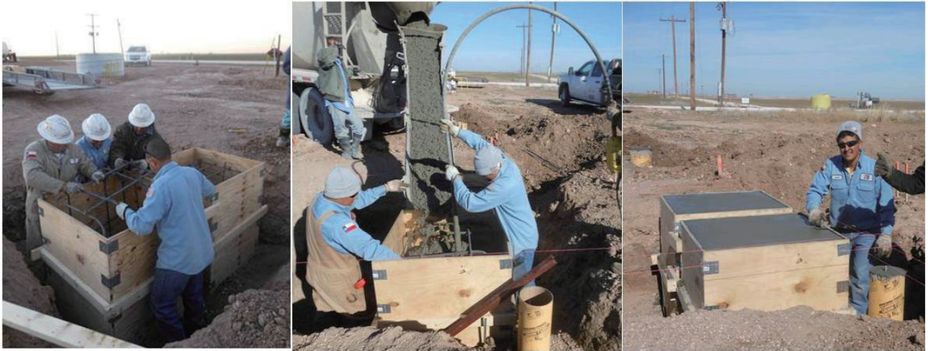
写真 11 重力計測用基台設置工事。辺長約 1 m の立方体上の鉄筋入りコンクリート台を 2 つ併設した。1 m 深掘削し、木枠を 2 つ設置し、あらかじめ組んだ鉄筋を置く。その後、コンクリートを流し込んで表面を整形した。同時に計測小屋外部に設置する円柱基台と竜巻対策として小屋自体を固定する円柱も設置した。
