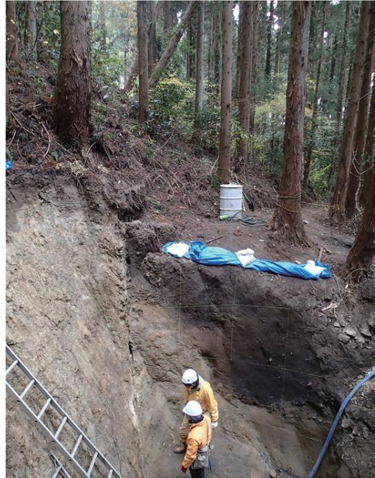
写真1 湯ノ岳断層のトレンチ調査の様子。2011年福島県浜通りの地震で現れた地表地震断層直下を掘削しました。
