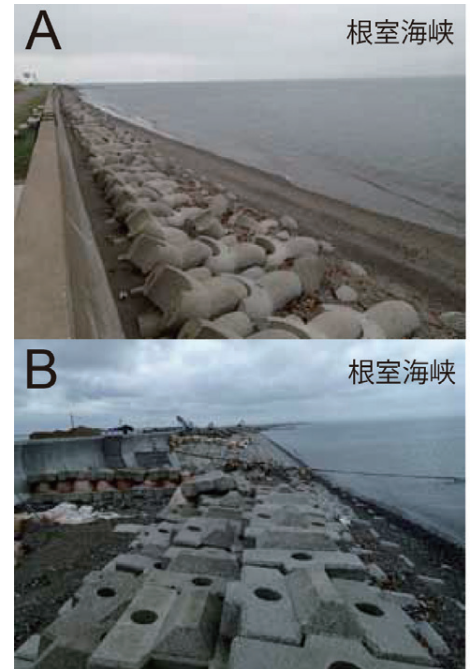
第2図 根室海峡側の護岸された海岸。海岸浸食対策として、現在も継続されている。A, Bの位置は第1図参照。
