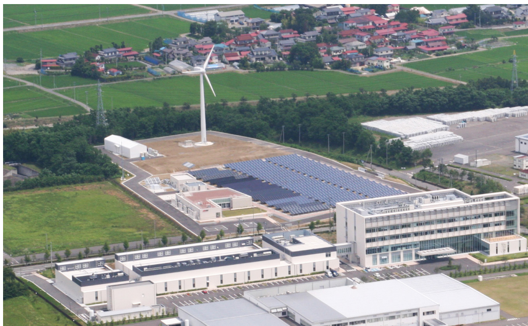
写真2 FREA全体の航空写真(2014年7月撮影)。風車および太陽光パネルが見えている部分が実証フィールド。風車は定格出力300kW、駒井ハルテック社製。ナセル(風車の軸受け、タービンがある部分)までの高さは42m、羽根の長さは16.5m。太陽光パネルは全部で2000枚、500kW。左列の200kW分では、国内メーカー8社、10種類のパネルの効率を比較している。中央列および右列の300kW分は、Qセルズ社製。
