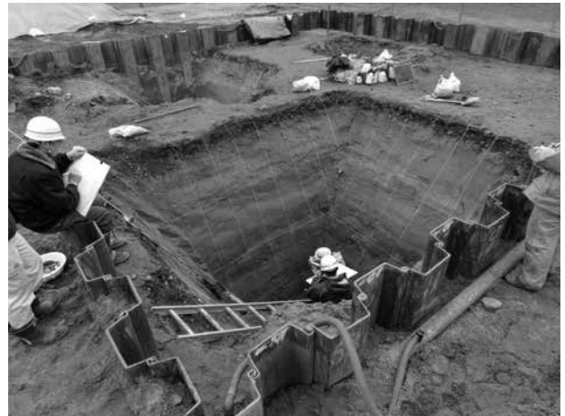
第3図 周囲を矢板で囲ったトレンチの全景（第1図のB地点）。
