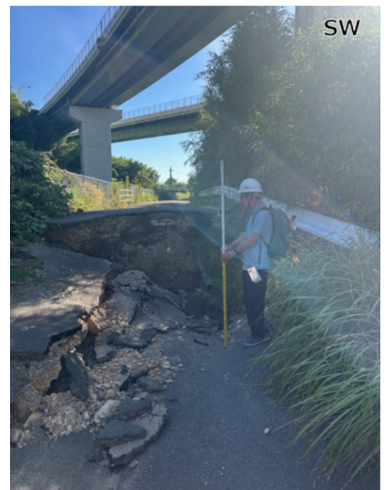
写真11 熊本県八代市上片町の八代JCT付近に見られる上下ずれ変位。上下ずれ変位量は約 130 cm。写真は南西方向に向かって撮影 (2026 年 7 月 31 日撮影)。
