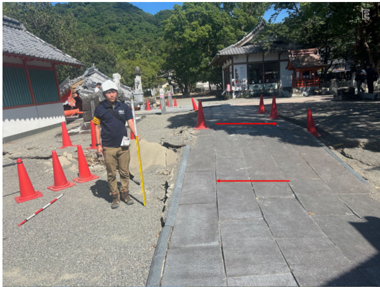
写真 12 熊本県八代市妙見町の八代神社境内に見られる右横ずれ変位。境内の参道を基準にした時の右横ずれ変位量は 95 cm。上下ずれ変位量は 39 cm 西低下。写真は東方向に向かって撮影 (2026 年 7 月 31 日撮影)。
