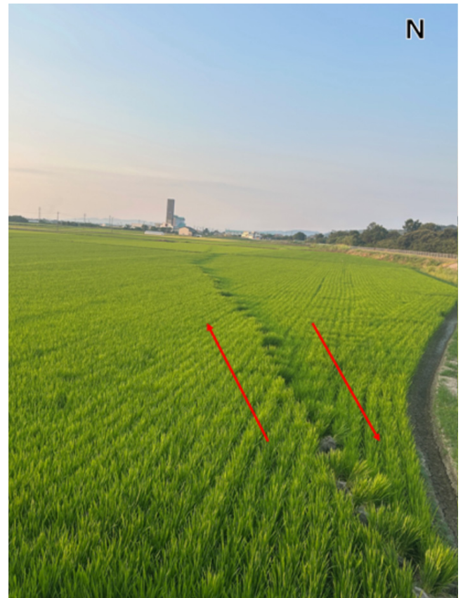
写真9 熊本県八代市岡町中の舗装道路～水田に見られる右横ずれ変位。道路の白線を基準にした時の右横ずれ変位量は120 cm, 上下ずれ変位量は16 cm 東低下。写真は北方向に向かって撮影 (2026年8月2日撮影)。
