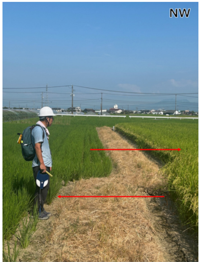
写真7 熊本県八代郡氷川町大野の水田に見られる右横ずれ変位。道の駅竜北の南に位置する。畦道を基準にした時の右横ずれ変位量は115 cm，上下ずれ変位量は19 cm 北西低下。写真は北西方向に向かって撮影（2026年8月2日撮影）。
