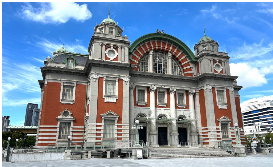
第1図 大正7年竣工の大阪市中央公会堂。構造は鉄骨煉瓦造三階建，地下一階。設計競技による岡田信一郎案をもとに，辰野金吾，片岡 安が実施設計を行った。ネオ・ルネサンス様式を基調としながらも躍動感を加味した意匠で，我が国の煉瓦造建築の到達点となった建築のひとつと評価され，国の重要文化財に指定されている。
