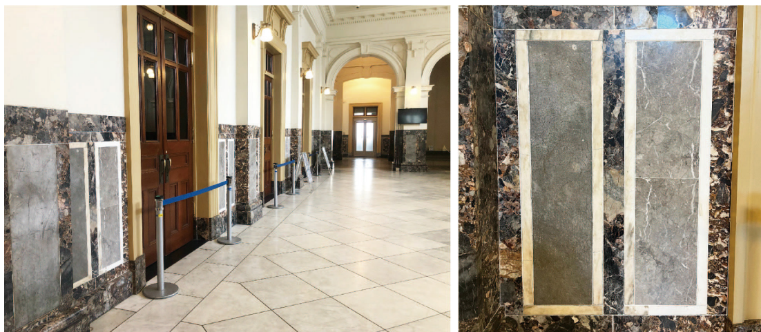
第2図 左写真：東正面玄関奥のロビー。このロビーや階段脇の腰壁の装飾や床に大理石が使用されている。右写真：ロビーの腰壁に使用される石材。縦方向に配置される2列の灰白色石灰岩のうち，左は建築当初からのオリジナルと思われる赤坂石灰岩産の「美濃霞」，右が補修時に貼られたと思われる代替の秋吉石灰岩産「長州霞」。左側のオリジナルは1ピースであるが，補修されたと思われる右側は上下2ピースに分けて貼られている。右側は枠組みの白色大理石や角礫質石灰岩も更新されている。
