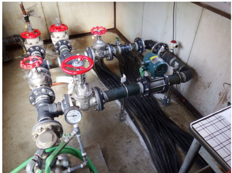
第2図 温泉モニタリングシステム(左)と温泉配管への接続例(右)。
