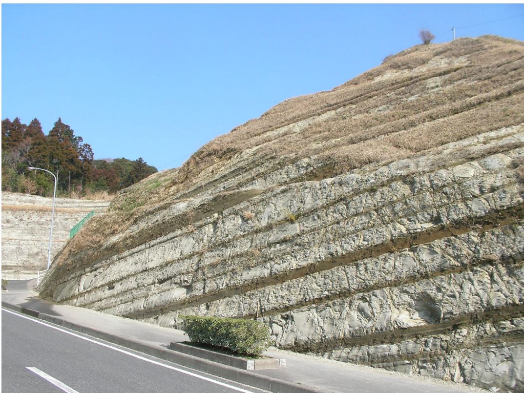
第13図 泥岩優勢砂岩泥岩互層（泥勝ち互層） 灰白色部が泥岩層で、暗褐色部がタービダイト砂岩層です。いすみ市文化とスポーツの森にて（いすみ市深谷）。
