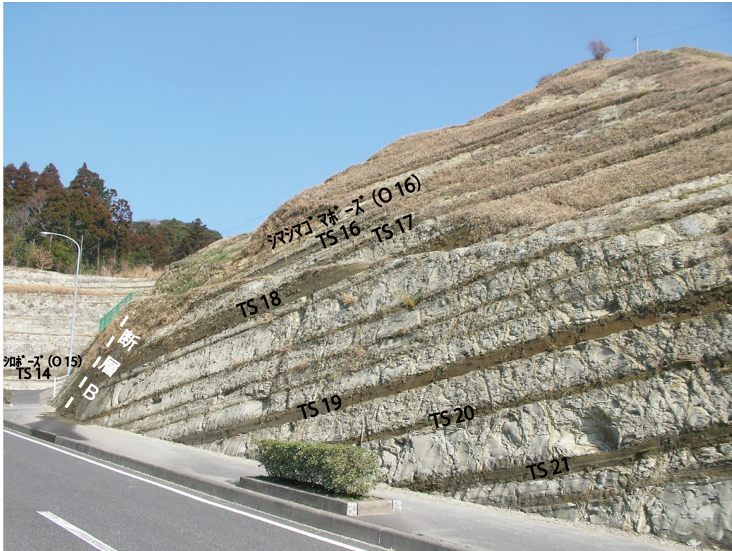
第 30 図 V字カーブを過ぎた下り坂沿いの地層 ここでは、シマシマゴマボーズ (O16) より下位の地層が露出します。灰白色は泥岩層で、褐色部はタービダイト砂岩層です。デブライト層はほとんど挟まれていません。
