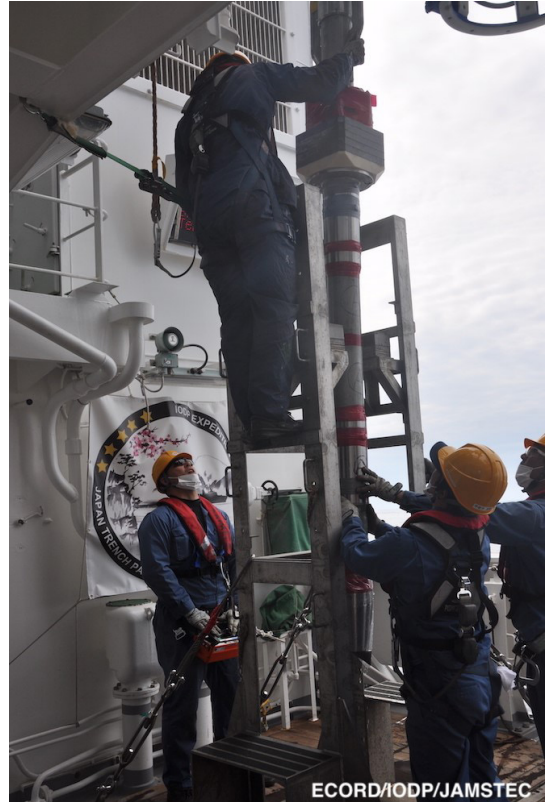
写真3 「かいめい」船上に揚収されたトリガーコアラー
