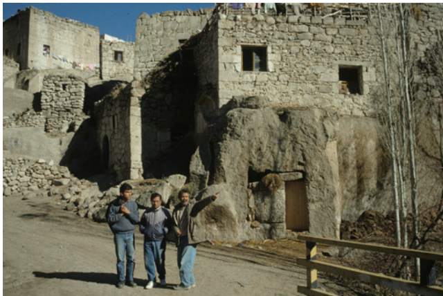
第14図 ウフアラの民家。 一部は自然の崖を掘り抜き、一部はクズルカヤ・イグニブライトを切り出して積み上げてできています。上の道路から歩いてくると、いつの間にか他人の屋根の上に登ってしまっていることに気が付きます。自然と一体化しています。手前はMTAの地質研究者。
