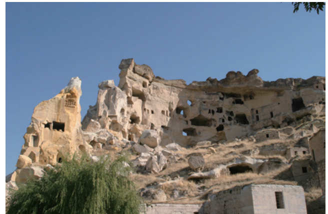
第15図 チャウシン。 教会の施設が地震などで崩壊し、今では利用が禁止されています。
