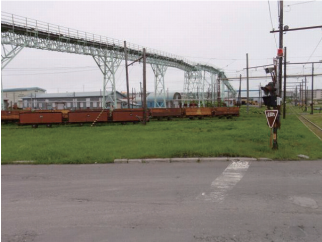
第7図 釧路市興津の釧路コールマイン構内。 石炭を積み出すベルトコンベヤーが坑口から続く。
