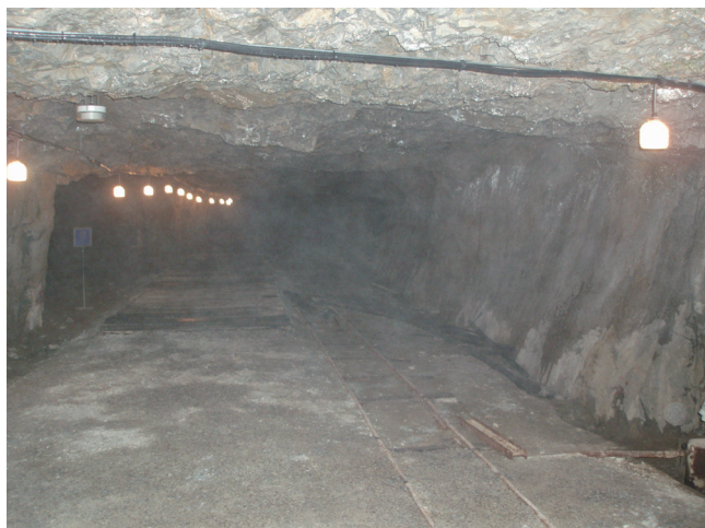
第6図 東北砕石工場石灰岩採掘坑道。
