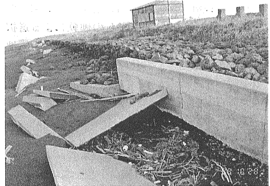
第13図 コムケ湖出口の導流堤東側における海岸浸食状況(1998年10月28日撮影)。
