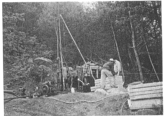
写真9 着々と進められるボーリング探査。林道の脇で、深さ200mほどのボーリングが行われていた。
