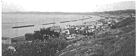
第8図 弧状に配置された離岸堤に護られた厚岸湾頭部の町並み.
