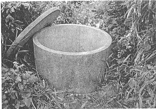
写真47-1 元の場所に戻された移動した円形コンクリート管と保護蓋。地上部のコンクリート管基部を固定したコンクリート型枠(母屋側)は破損しなかった[服部撮影(1997.5.18)].
