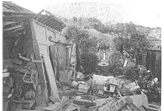
写真46-5 舗田氏邸東別棟、温水器、掘り井戸などの被災状況。矢印は掘り井戸、その手前が横倒しになった円筒形の温水器、右端が物置[舗田雅人氏撮影(1995.1.20)]。
