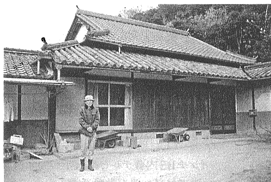
写真35 鍔葺き屋根造りの大畑氏邸母屋. 開口地割れから3~5mの距離に建つ. 右手の鍵形部分は風呂と便所[服部撮影(1996.1.29)].
