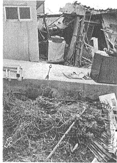
写真46-4 舗田氏邸北側の野島東地震断層の通る場所の被災状況。コンクリート製平屋と右側の母屋の中間を地震断層が通る。手前の畑には地割れができ、母屋は右側に倒壊。コンクリート小径は地震断層の位置(矢羽印)で無傷[水野清秀氏撮影(1995.1.26)]。
