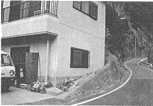
写真40-1 野島東地震断層から100m南方の花崗岩岩盤上に建つ無傷の住宅(渡井口新邸)[服部撮影(1996.1.29)]。
