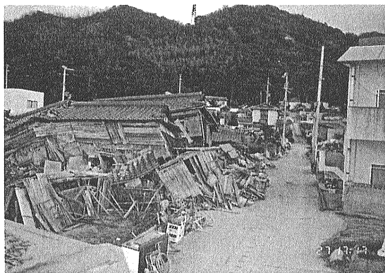
写真43 野島漁港周辺の家屋の被災状況。海岸岸壁から全壊した野島八幡神社が正面先方に見える。その間の約150mの海岸低地は沖積層からなる[服部撮影(1995.1.27)].
