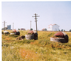
6. 幹線鉄道を守るトーチカの列(デュロス市近郊)、トーチカに使用された鉄は、低品位のラテライト鉄鉱石から精錬された、トーチカは国内各地に多数建設され、使用された鉄鉱石は莫大な量に達する。(アルバニア)
