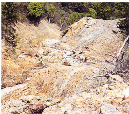
10. 谷の流下堆積物(1997年5月19日撮影)。上流側から望む。右手奥が本号36頁の第3図地点aの乗り上げ部分に相当する。その左手奥の斜面では、表層が削剥され、土砂が通過した痕跡が残る。手前の堆積物には、流下方向に平行な縞模様が認められる。
